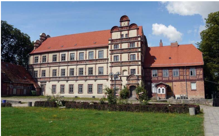
Von den Gutshäusern und Schlössern, die in der DDR der Allgemeinheit dienen, etwa als Schulen, drohen viele zu verfallen. So zum Beispiel in Mecklenburg-Vorpommern das Schloss Gadebusch.
